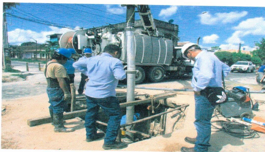
Mejora del sistema de colectores
