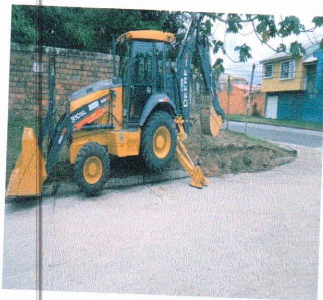
Retroexcavadora en Iquitos
