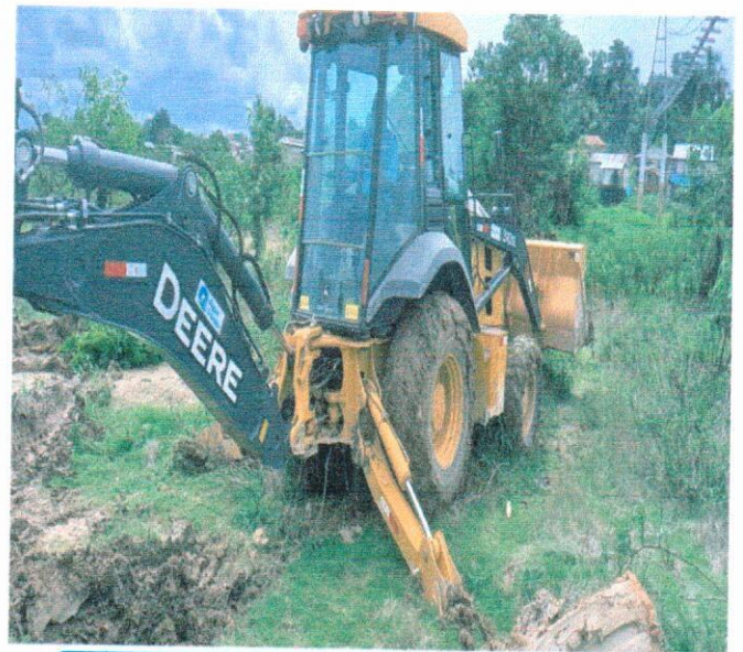
Retroexcavadora en Requena
